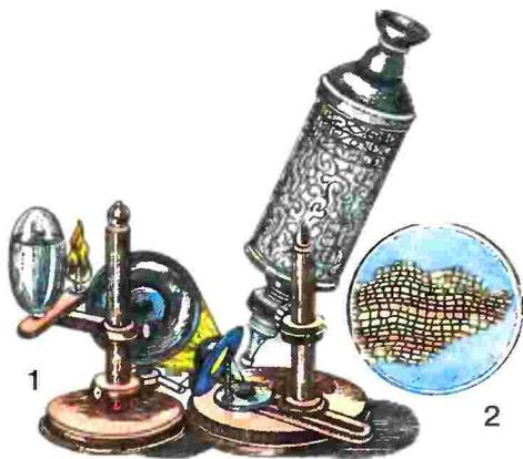
Рис. 17. Микроскоп Р. Гука (1) и клетки пробки (2)
