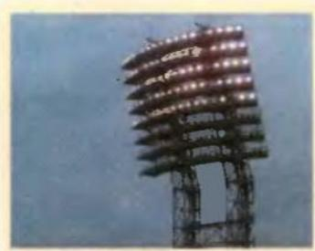
**Рис. 3.2.** Для освещения стадионов используют дуговые лампы
