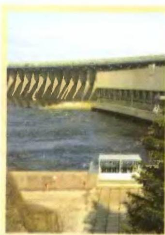
**Рис. 1.45.** На гидроэлектростанциях падающая вода (механическая энергия) вращает турбины, которые вырабатывают электрическую энергию
