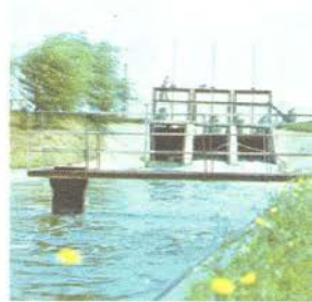
Участок Северо- Крымского канала
