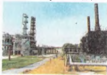
Рис. 27. Завод по подготовке природного газа (Полтавская обл.)
