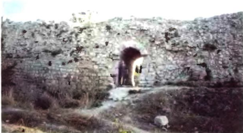
Стены Херсонеса. Фото
