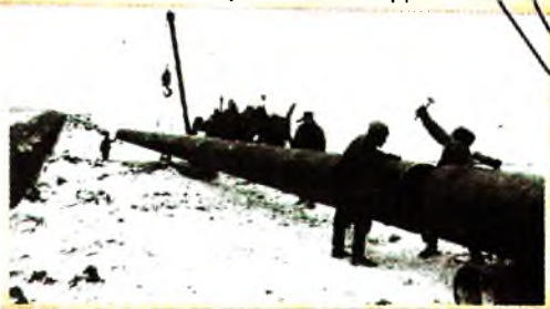
На строительстве газопровода «Шебелинка – Харьков», 1956 г.
