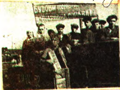
Группа колхозников отправляется на строительство Каховской ГЭС. Ровенщина, 1951 г.
