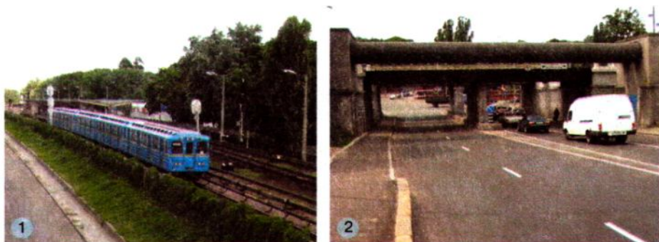
Рис. 198. Пути метрополитена (1), эстакада (2)
