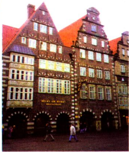
Рис. 195. Крутые крыши домов в Германии (г. Бремен)
